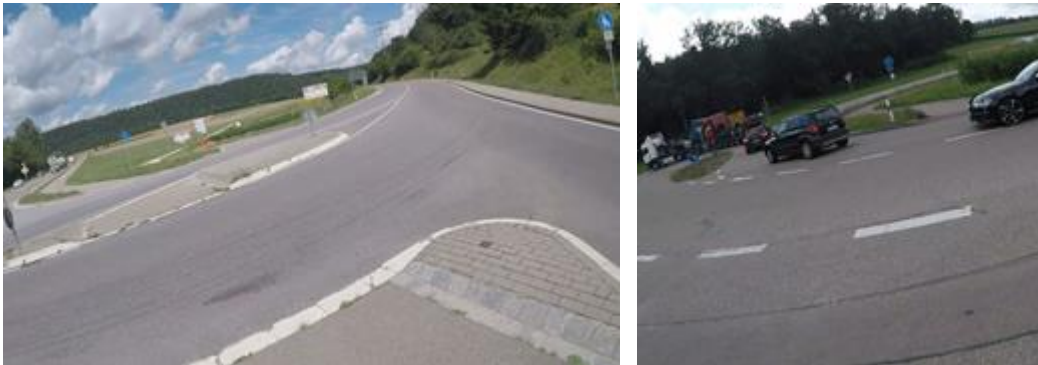
Abbildung 35: unsichere Querung außerorts (Einmündung K 3009/ B 19 sowie Einmündung Nattheimer Straße/ B 466
