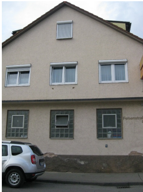
Gebäude vor der Modernisierung
